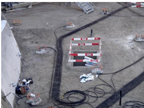
03_MPestalozzi_TheCircle (4608x3456 Pixel) Die Pfahlfundamente sind für die Geothermie erschlossen.
