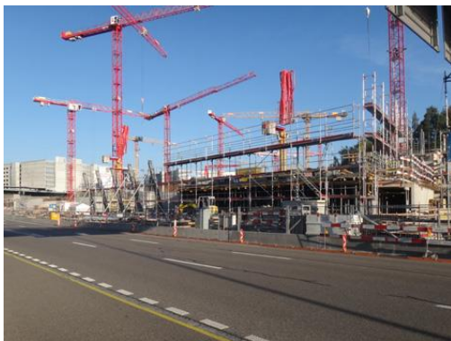
01_MPestalozzi_TheCircle (4000x3000 Pixel) Die schrägen Stützen deuten die äussere «Mauer» von The Circle an.
