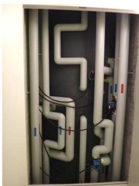
03_MPestalozzi_Stettbachstr (3456x4608 Pixel) Abschnitt des Speichertanks
