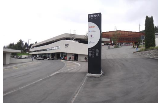
02_MPestalozzi_Stenna (3648x2736 Pixel) Rampe zu Bahnstationen, Bushaltestelle
