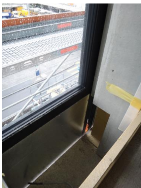
05_MPestalozzi_Kunsthaus (2629x3548 Pixel) Fensterdetail, fehlender Bodenaufbau
