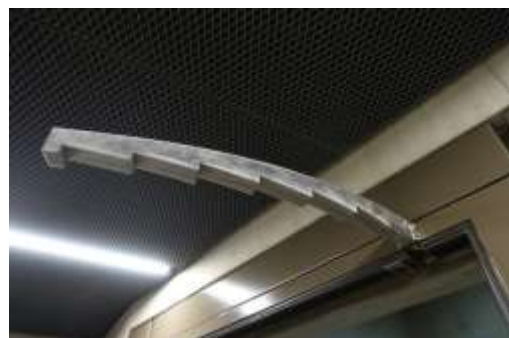
04_MPestalozzi_Kriminalabteilung Arretierungsschiene einer Zellentür (5472x3648 Pixel)
