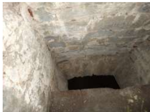
03_MPestalozzi_Kasematten (4608x3456 Pixel) Pulverdampfabzug
