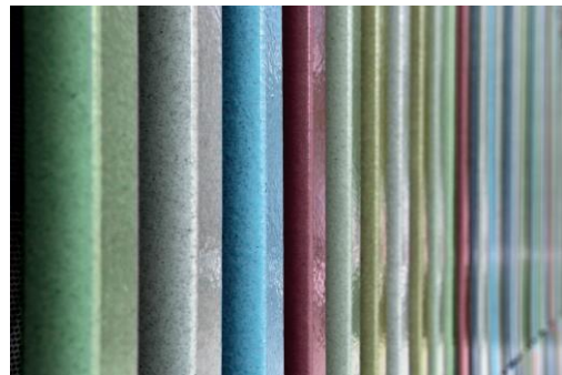
02_FassadenAtlas_Museum Brandhorst_Bild_Christian_Schittich (1594x1063 Pixel) Fassadenstäbe aus Keramik am Museum Brandhorst in München Foto Christian Schittich
