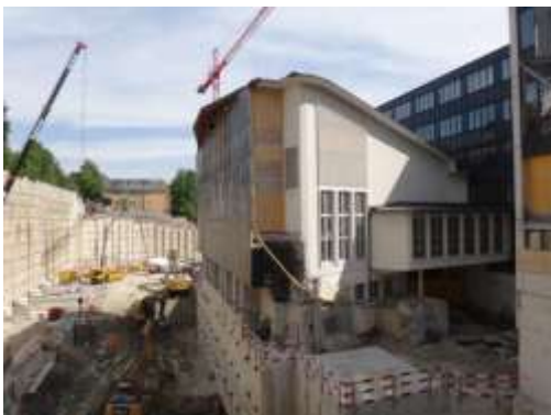
03_MPestalozzi_ETH-GLC (3456x4608 Pixel) Niveau Physikstrasse mit abgefangenem Scherrersaal
