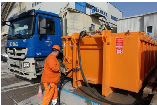
03_MPestalozzi_CO2SpeicherBeton Das Klimagas wird von oben und unten in das Granulat eingebracht. (5472x3648 Pixel)
