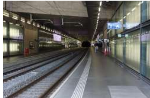
02_MPestalozzi_CEVA_Genf Das Tunnelportal in der Station Lancy- Bachet wird von zwei weiteren Verkehrsebenen überlagert. (5472x3648 Pixel)
