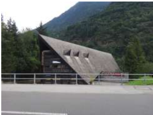
01_MPestalozzi_Blenio (4608x3456 Pixel) Cinema Teatro Blenio, Acquarossa 1957, Architekt Giampiero Mina
