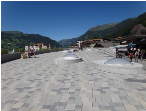
03_M_Pestalozzi_BOberland (5616x3744 Pixel) Dach der Zentrumsüberbauung Eiger+, Grindelwald
