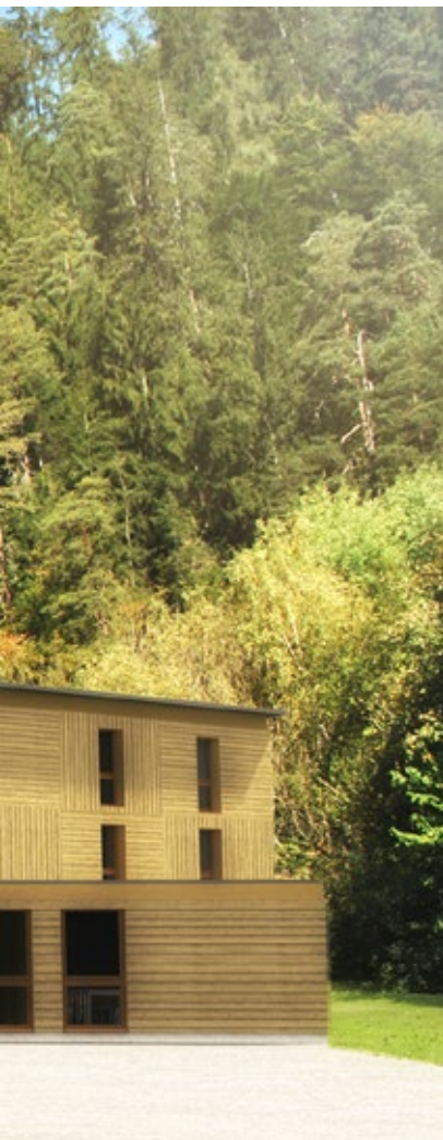
Auf der Flusseite befindet sich der Eingangspavillon, in dem auch Gemeinschaftsräume und eine Schulküche untergebracht sind.
